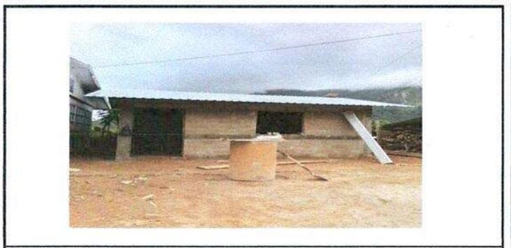
Foto 6: Sustitución de muro perimetral de madera por block en cocina, Reparación de columnas de madera por concreto en cocina, Instalación de block en cocina
