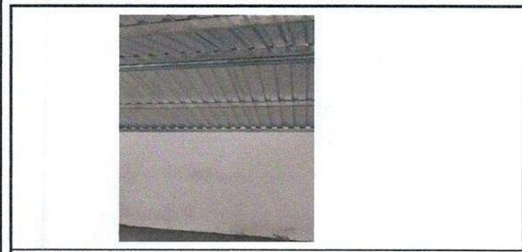
Foto 5. Sustitución de lámina, por lámina troquelada aluzinc calibre 26 en cocina, Sustitución de elementos de fijación en cocina. Sustitución de estructura de soporte de madera, por metal en cocina
