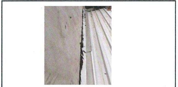
Foto 2: Sustitución de lámina, por lámina troquelada aluzinc calibre 26 de aulas, Sustitución de capote de lámina para lámina troquelada de aulas
