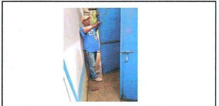
Foto 4: Mantenimiento a estructura (lijado, cepillado, sujeciones, aplicación de pintura)
